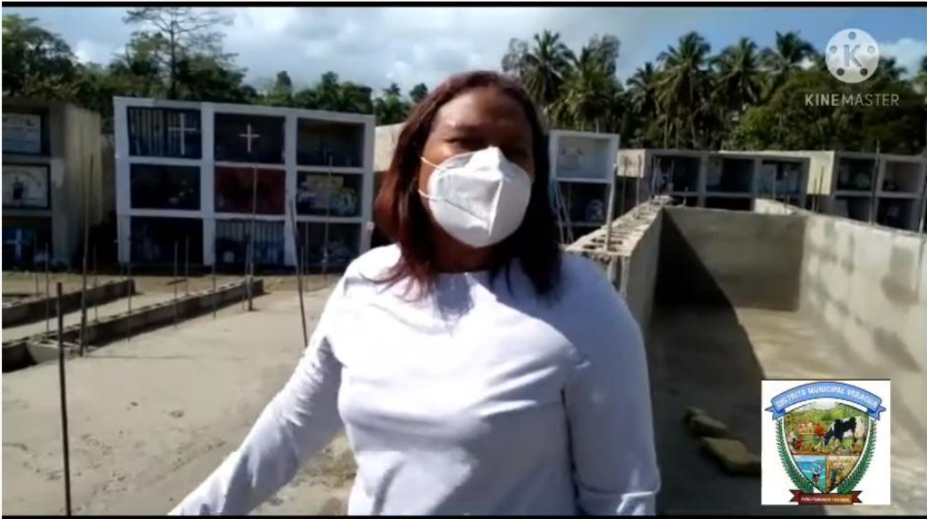
Construcción Nuevos Nichos Cementerio Veragua
